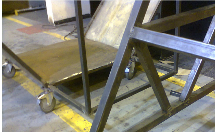
Figura 3.18 Montaje de llantas para la cabina de operación.
