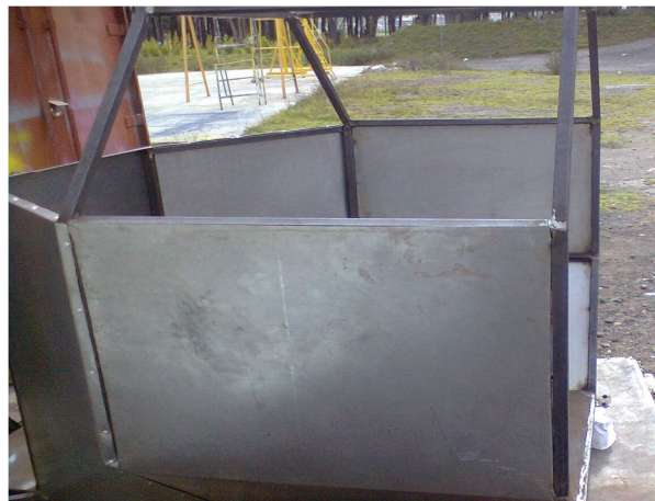
Figura 3.19 Fijación de láminas de tol para la cabina de operación.
