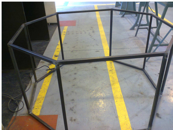
Figura 3.17 Armado con suelda eléctrica la cabina de operación.
