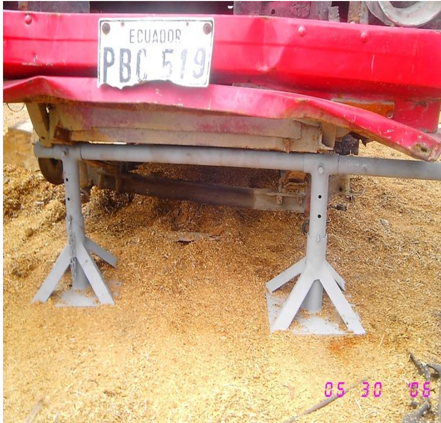
Figura.3.16. Colocación de soportes de seguridad.
