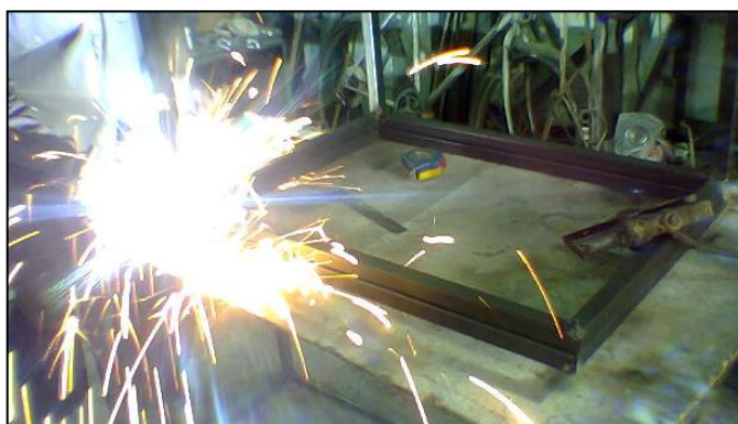
Figura 3.3. Construcción de la Estructura.
