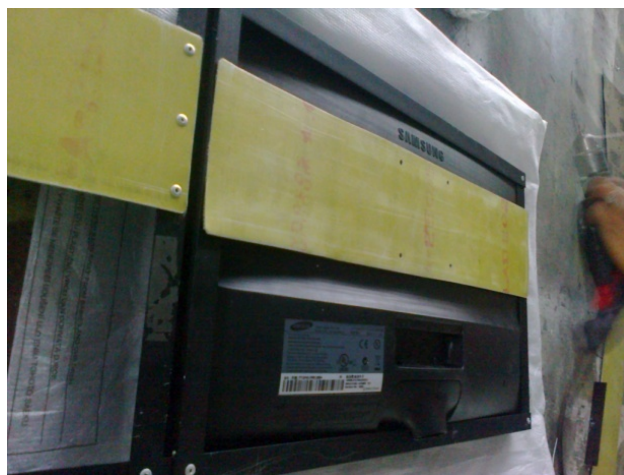
Figura 3.12 Construcción de soporte de pantallas
