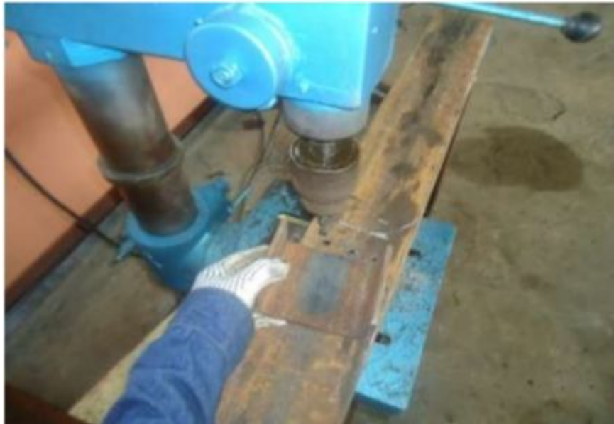
Figura 3.6. Perforación de la Columna
