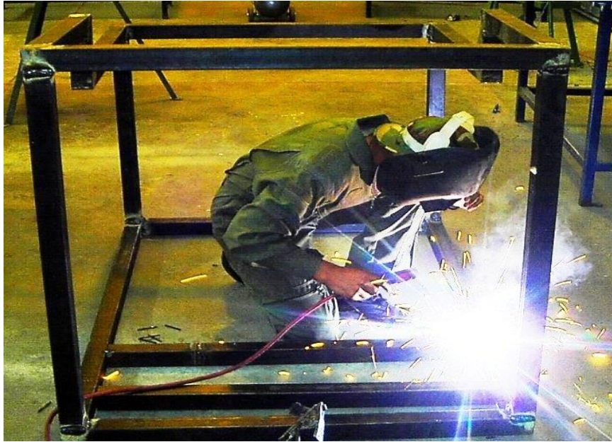
B.1.- Proceso de soldado de la estructura principal
