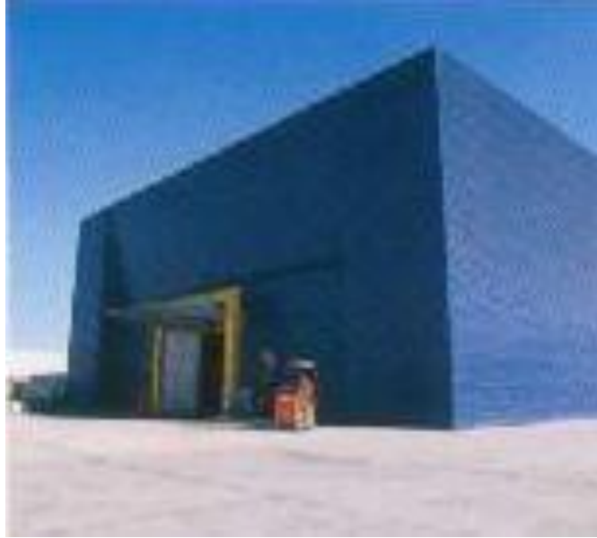
Figura 1.28 Bodega de equipos de pintura y pinturas.
