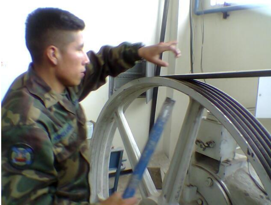
Figura 3.6 Desmontaje de la red neumática antigua.
