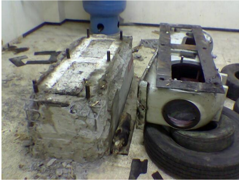
Figura 3.8 Desmontaje del compresor de la base.
