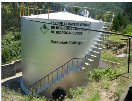
Imagen 7.36: Tanque terminado después de su mantenimiento.
