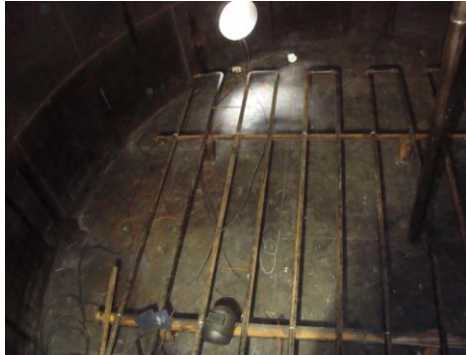
Imagen 7.37: Panorámica de la construcción del serpentín dentro del tanque API2, y manhole por donde se debe ingresar todo el material y equipos.
