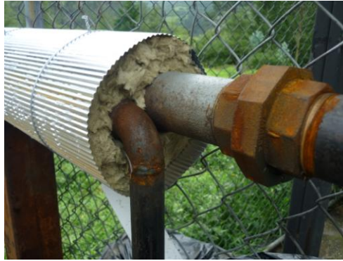
Imagen 7.62: Detalle del sistema de aislamiento y recubrimiento.
