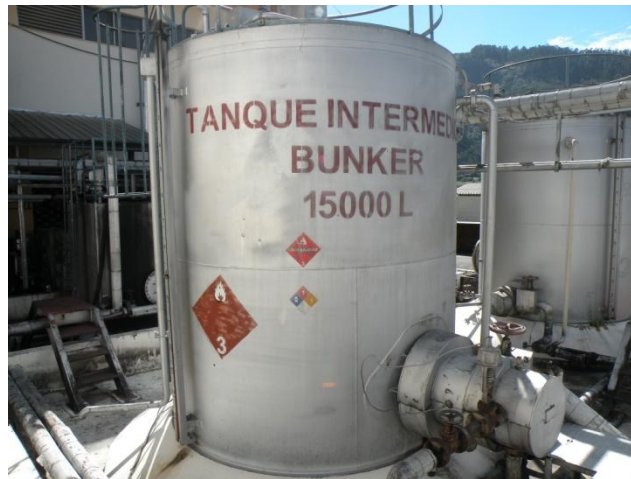
Imagen 2.2: Tanque Intermedio de Bunker.
