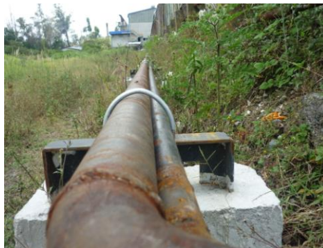
Imagen 7.19: Configuración de tubería acompañante de vapor.
