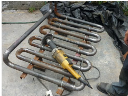
Imagen 7.44: Eliminación de oxido del serpentín de la fosa de rebosamiento.
