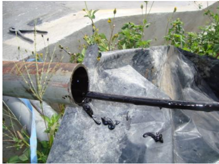
Imagen 7.12: Extracción del tubo de cobre.
