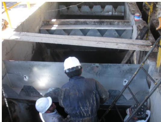
Imagen 7.23: Instalación de rebosaderos.
