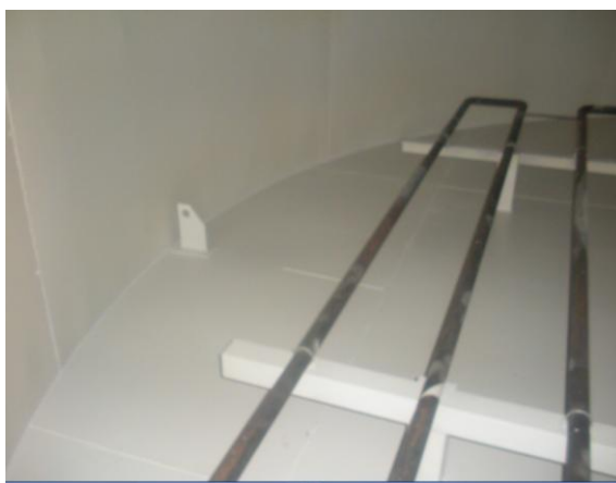
Imagen 7.35: Terminado de sandblasting dentro del tanque API2.
