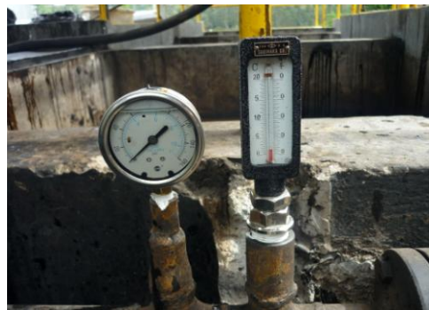
Imagen 7.52: Instalación de manómetros y termómetros para medición de presión y temperatura en la línea de vapor.
