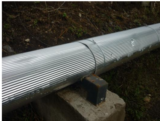
Imagen 7.63: Recubrimiento con lámina de aluminio a lo largo de la línea.
