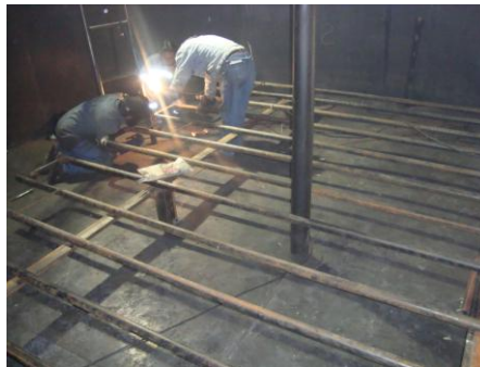
Imagen 7.38: Soldadura del serpentín dentro del tanque con proceso SMAW y E6011.
