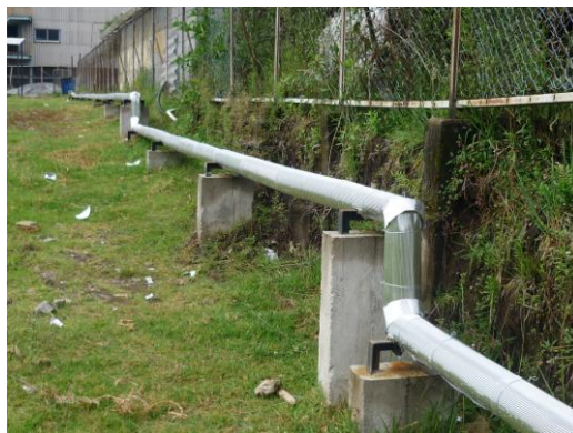
Imagen 7.64: Panorámica de la línea ya aislada y recubierta..
