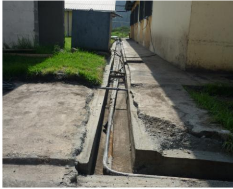
Imagen 7.59: Canal recién fundido.
