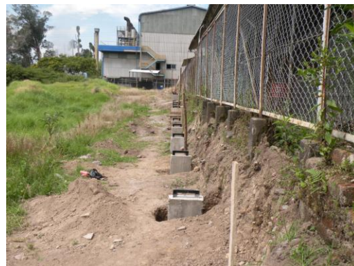
Imagen 7.8: Panorámica de la fundición de bases.
