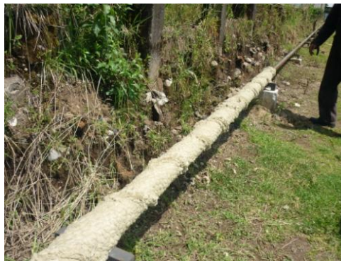
Imagen 7.60: Aislamiento de las líneas de cieno y vapor a lo largo de toda su extensión.
