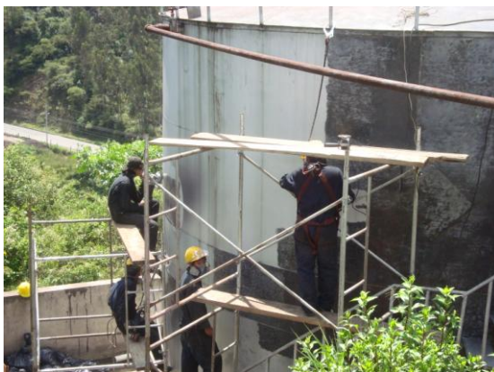
Imagen 7.34: Mantenimiento al tanque de almacenamiento API2.
