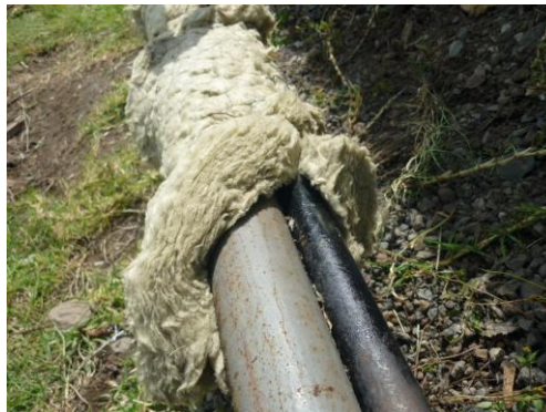
Imagen 7.61: Detalle del método de aislamiento.
