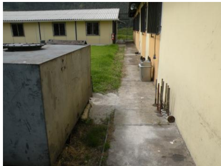
Imagen 7.9: Sector en el cuál la tubería original está bajo tierra
