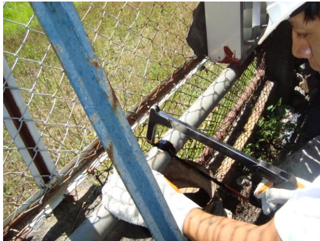
Imagen 7.1: Corte de tubería original con arco de sierra
