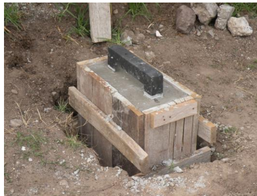
Imagen 7.7: Encofrado y fundición bases.
