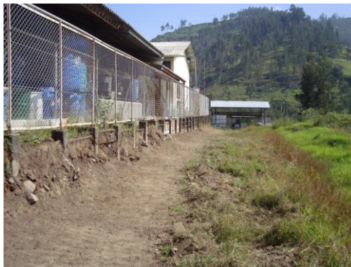
Imagen 7.5: Terreno nivelado, por donde atravesarán las tuberías de cieno y vapor
