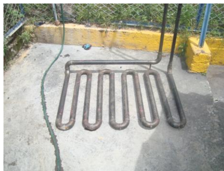
Imagen 7.26: Serpentín de la fosa de rebosamiento terminado.
