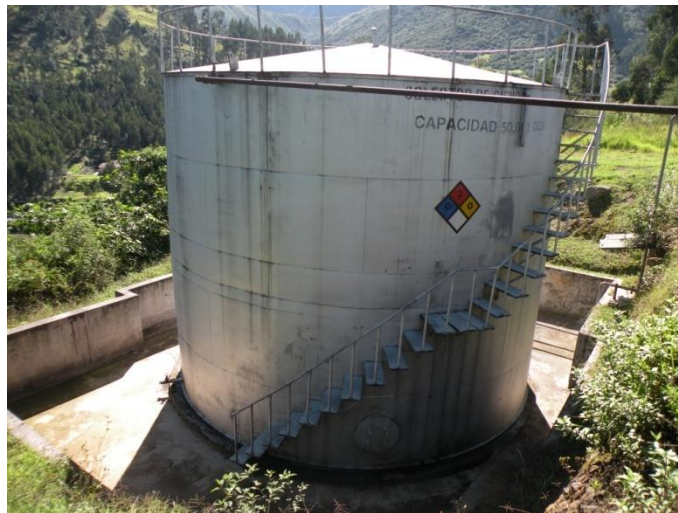
Imagen 2.3: Tanque de Almacenamiento de Cieno API2
