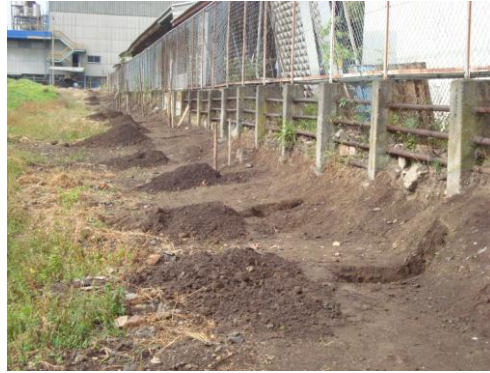
Imagen 7.6: Excavación de plintos sobre terreno nivelado
