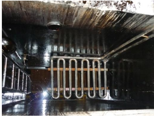
Imagen 7.45: Colocación del serpentín dentro de la fosa de rebosamiento.
