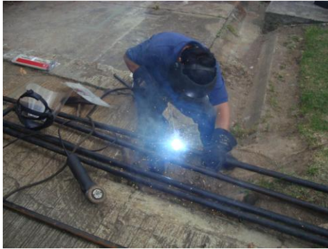
Imagen 7.15: Soldadura de Tubería con E6011.
