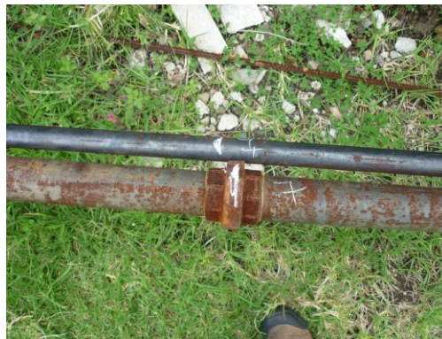
Imagen 7.16: Ensamblaje de de tubería de cieno con universales y soldadura de tubo de vapor.
