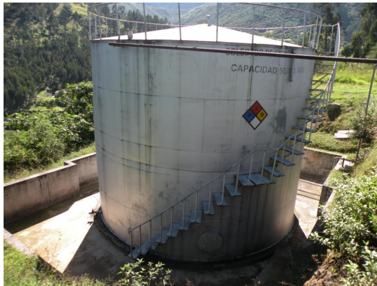
Imagen 7.33: Tanque de almacenamiento de cieno API2, antes de su mantenimiento y sandblasting..
