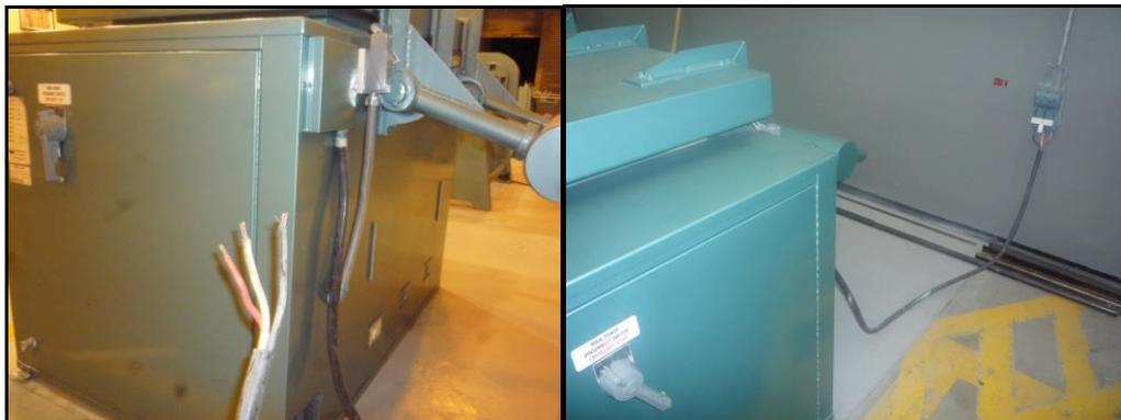
Foto 6.32 Conexión eléctrica del horno (antes-después)
