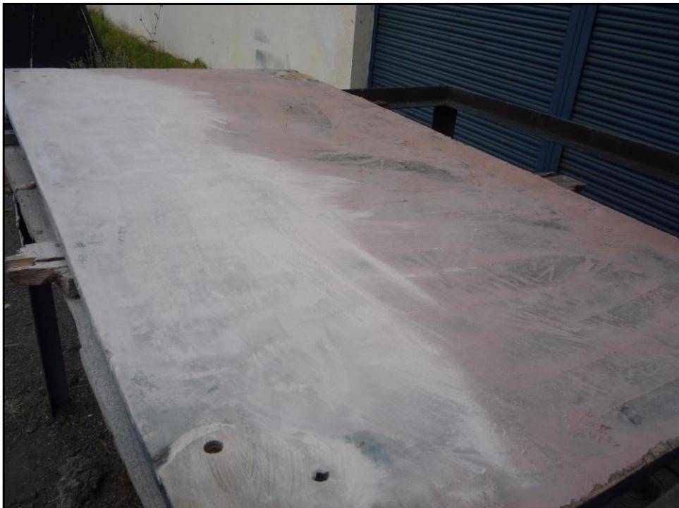
Foto 6.54 Colocación de masilla plástica para reparar daños en los tableros
