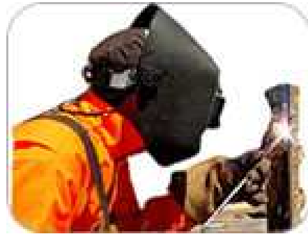
Figura N°5.5: Soldadura por arco eléctrico.
