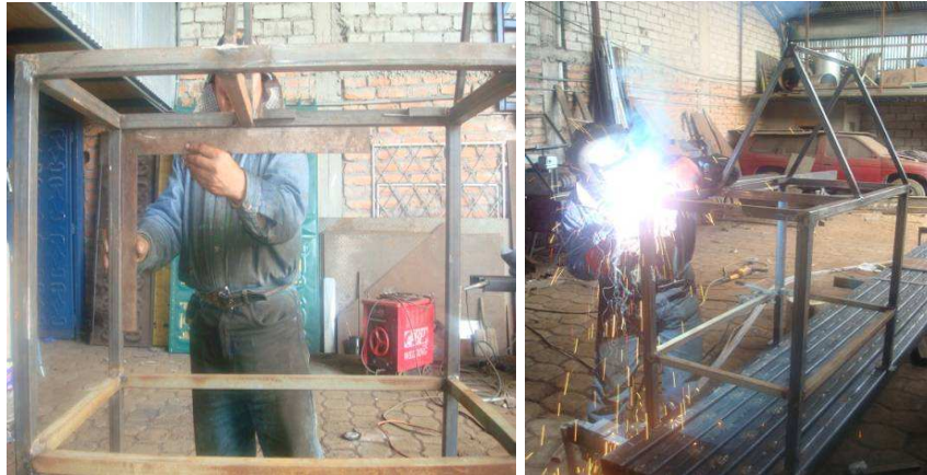
FIGURA 5.20: Construcción de la mesa transportadora.
