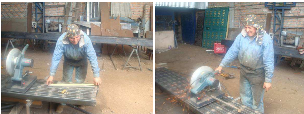
FIGURA 5.19: Construcción de la mesa transportadora.
