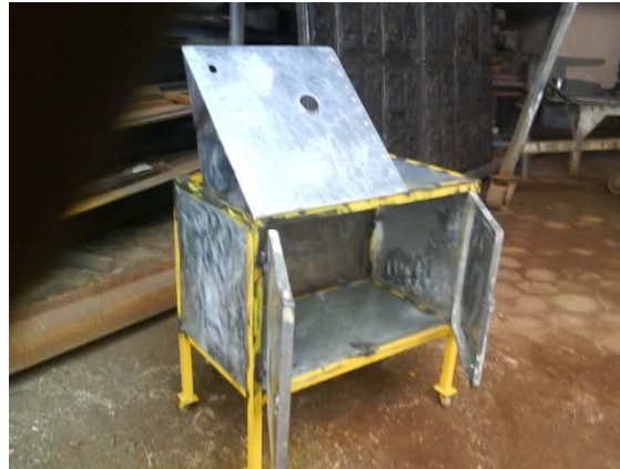
FIGURA 5.22: Construcción de la base para el tablero principal.
