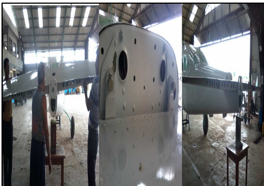
Figura 3.27: Instalación del estabilizador Horizontal.
