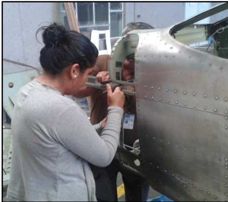
Figura 3.21: Remachado de los refuerzos de los canales.
