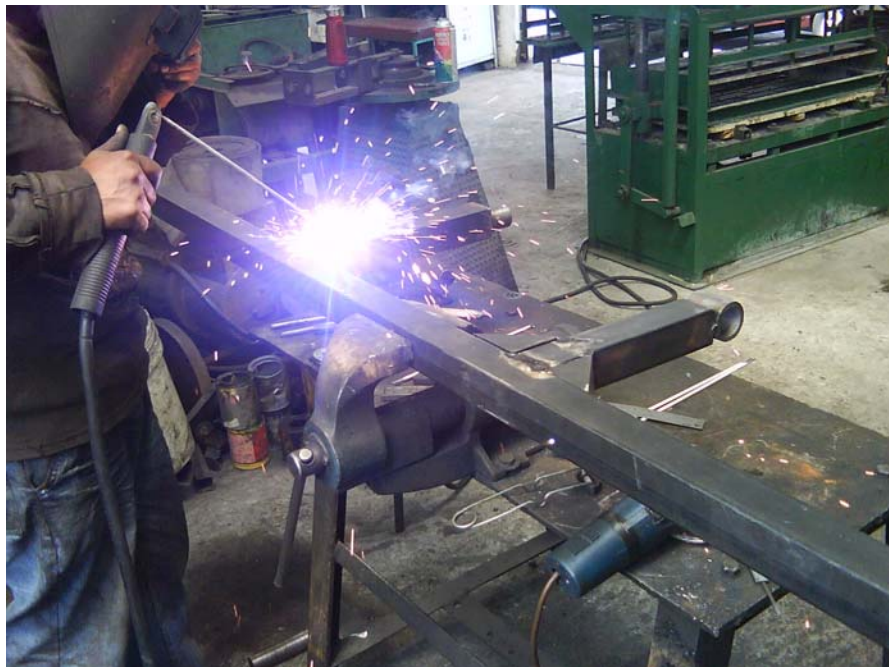
Figura Nº 5.14: Proceso de soldadura de las columnas de soporte.
