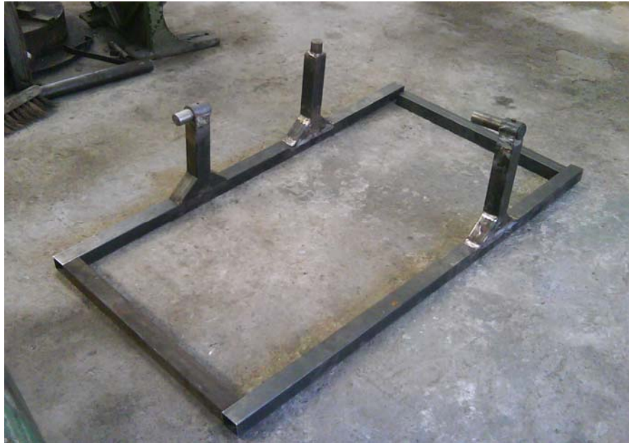
Figura N° 5.12: Construcción de la base de estructura principal.
