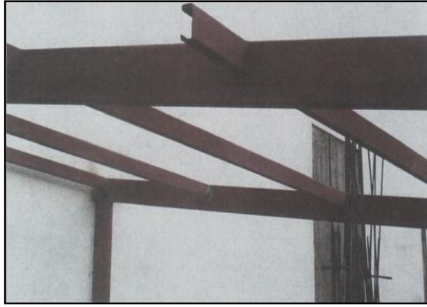
Fig. 3.3 Soldadura para las correas Fuente: Cbos. Ramos Rolando
