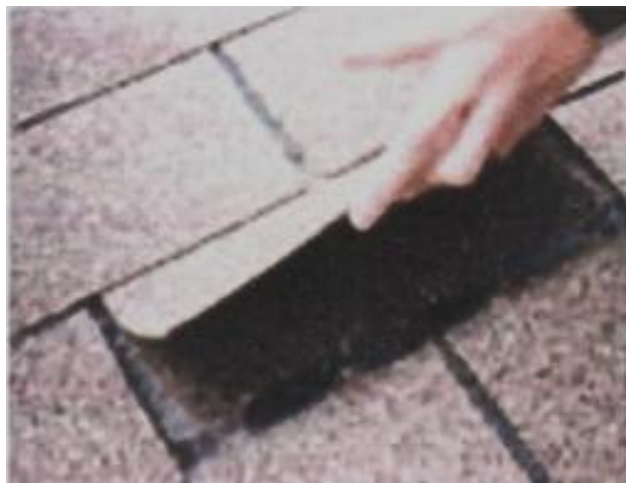
Fig. 2.9. Características de los techos Fuente: Enciclopedias de hangares (El Carl Rickard Nyberg)
