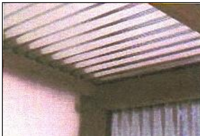
Fig. 3.8 Instalación de las láminas de zinc Fuente: Cbos Ramos Rolando
