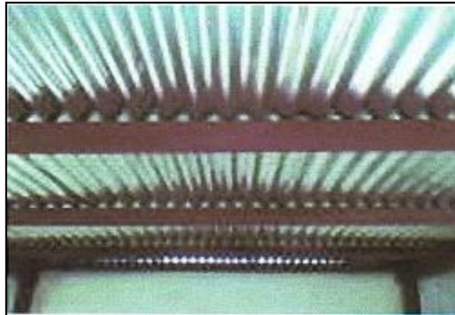
Fig. 3.7 Instalación de las láminas de zinc Fuente: Cbos. Ramos Rolando
