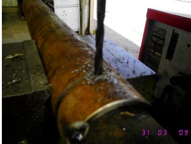
Figura No. 6.7 Perforación Tubos
