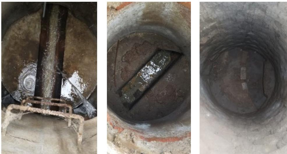
De igual manera se analiza el estado del zócalo con 61 pozos en buen estado, 23 pozos en estado regular y 11 pozos en mal estado, los pozos en buen estado representan el 61%, el 24% y el 12%
