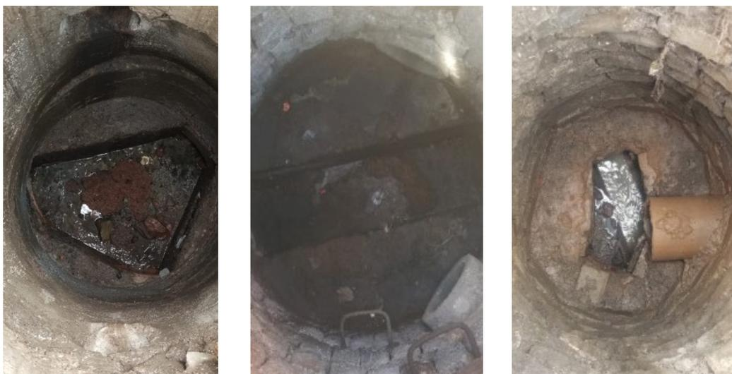
El estado del fondo de los pozos también se analiza por bueno, regular y malo y se tiene que 60 están en buen estado, 23 en regular estado y 11 en mal estado que representan el 64%, 24% y 12% respectivamente. En la **Figura 21**, también se puede apreciar el estado del fondo de los pozos.
