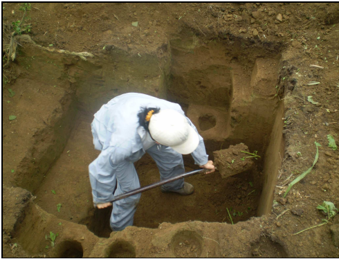
Foto 23. Construcción de calicata 4.
