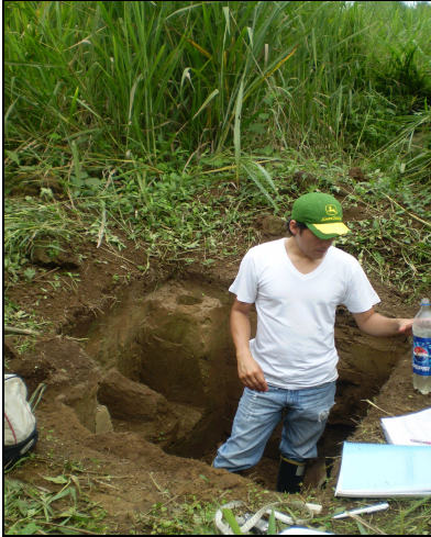
Foto 11. Construcción de la calicata 2.
