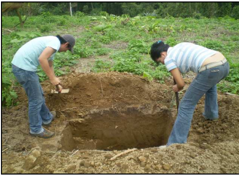
Foto 17. Construcción de la calicata 3.
