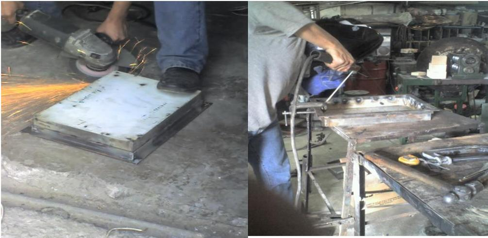
**Figura 4.5 Construcción de la puerta**
