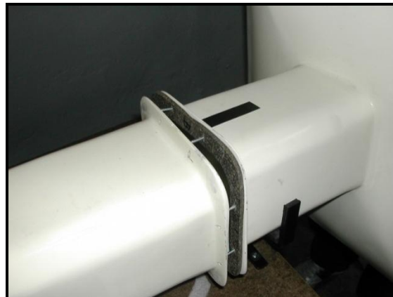
Figura 5.30.- Instalación cono de succión
