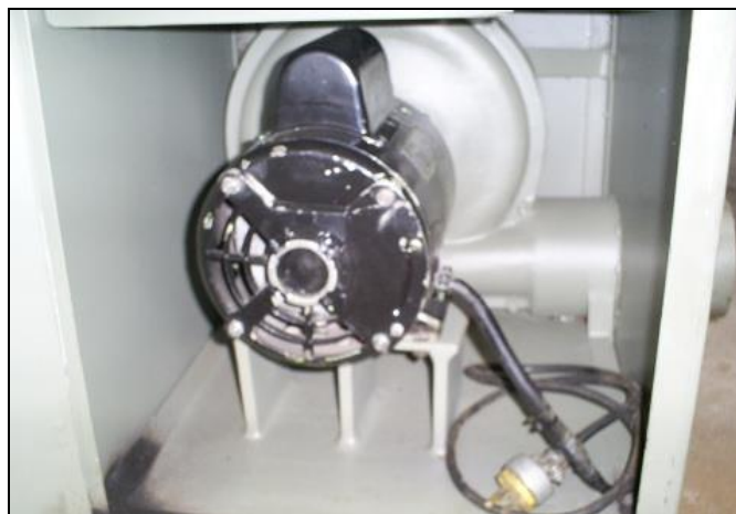
Instalación del motor eléctrico
