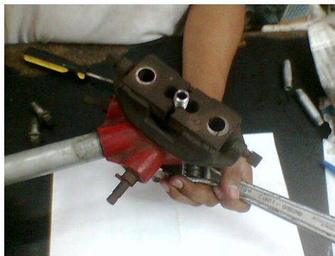
Figura 3.2 Construcción de la rosca.
