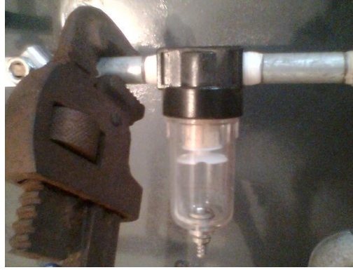
Figura 3.7 Ensamble de filtro de aire.
