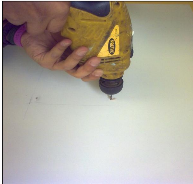
Figura 3.13.- Perforación para BSI.
