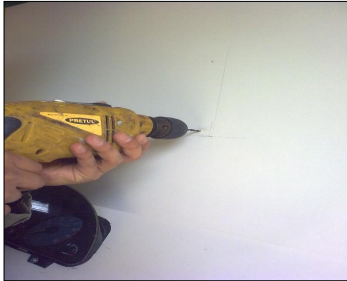
Figura 3.11.- Perforación para BM34.
