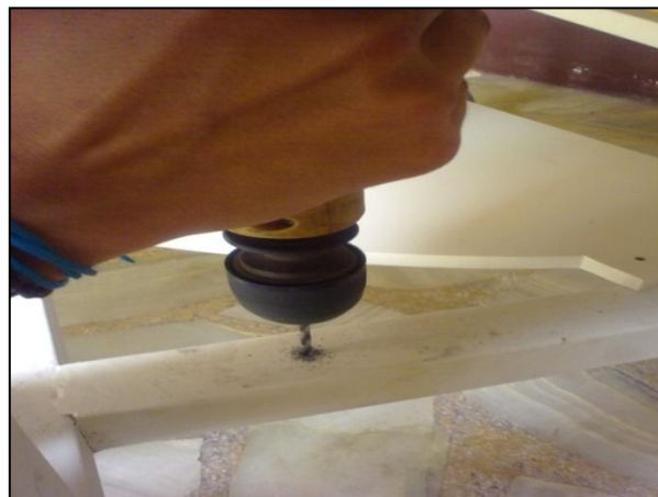
Figura 3.17.- Perforación en tubo para base de faros.
