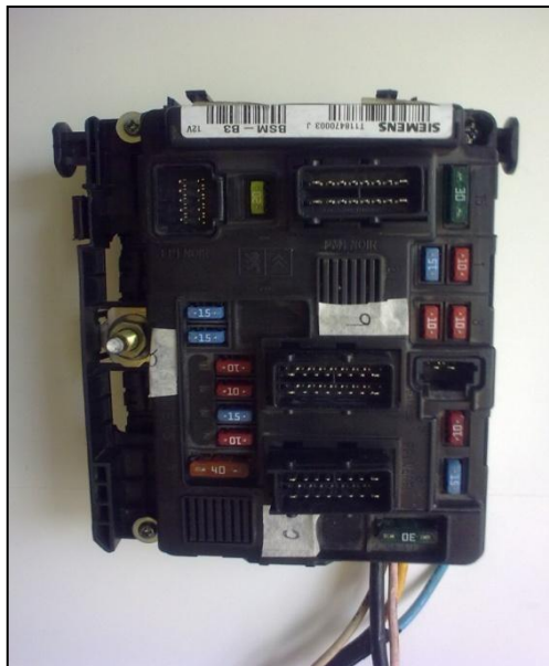
Figura 3.12.- BM34 fija al Tablero.
