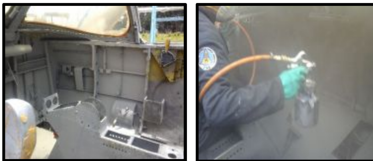
Figura 25. Pintado de la cabina
