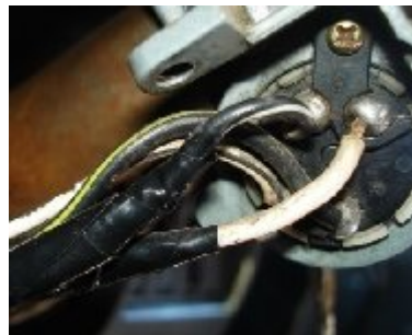
Figura 4.11. Cable de alimentación (auto)
