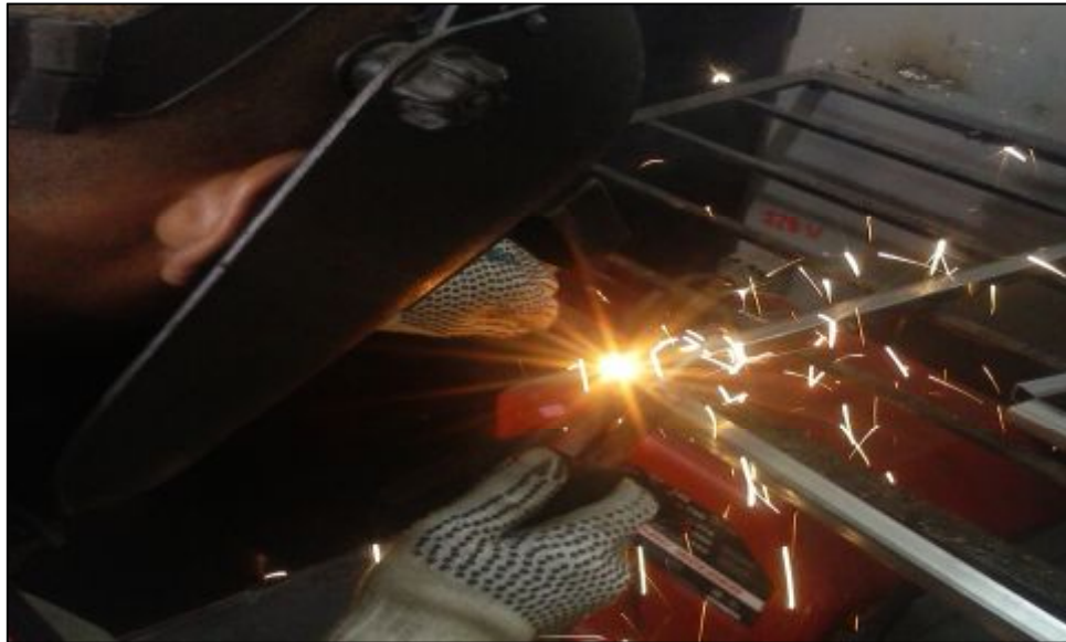
Figura 57. Proceso de soldadura en estructura
