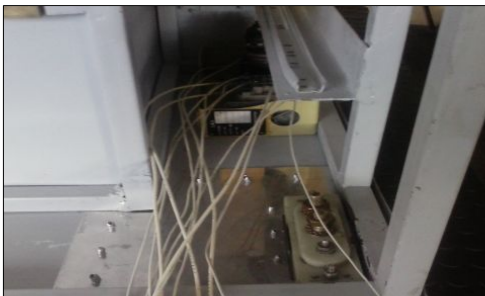
Figura 44. Instalación de relés y receptáculo de 28 VDC
