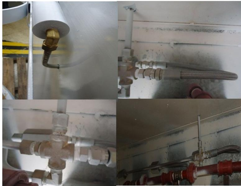
**Figura 67.** Instalación de las conexiones del manifold
