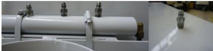
**Figura 64.** Instalación del manifold
