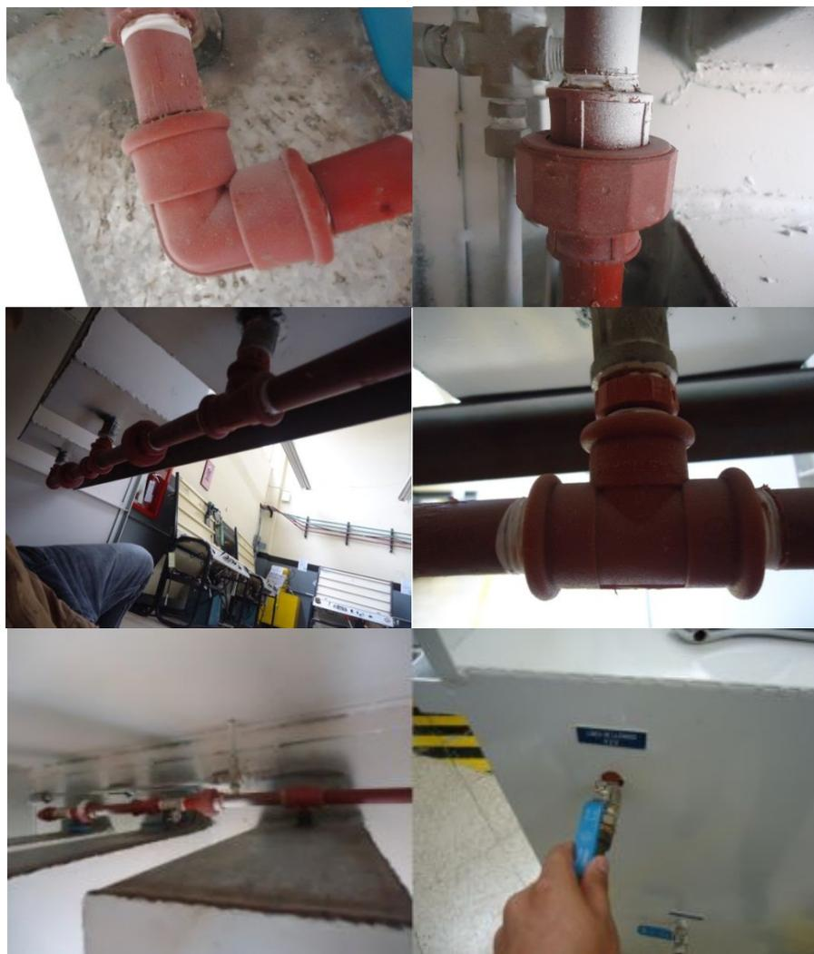
**Figura 69.** Instalación del sistema de agua del banco de llenado de O<sub>2</sub>
