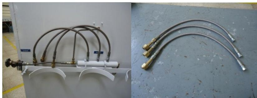
**Figura 68.** Instalación de las mangueras flexibles del manifold.
