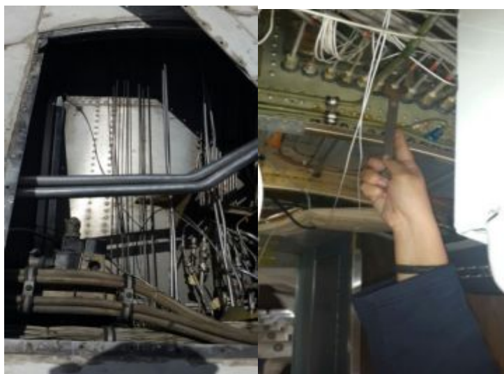
Figura 31: Revisión de cañerías parte superior del avión
