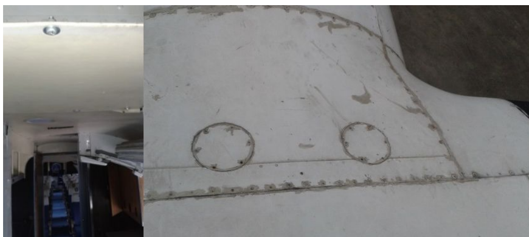
Figura 37: Instalación de accesos
