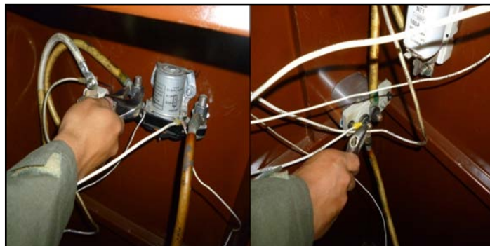
Figura 73. Conexión de cables eléctricos de N°1
