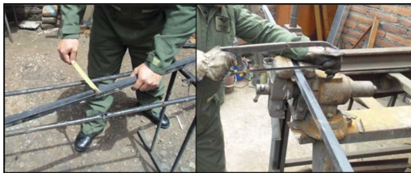
Figura 65. Construcción de la estructura del tablero
