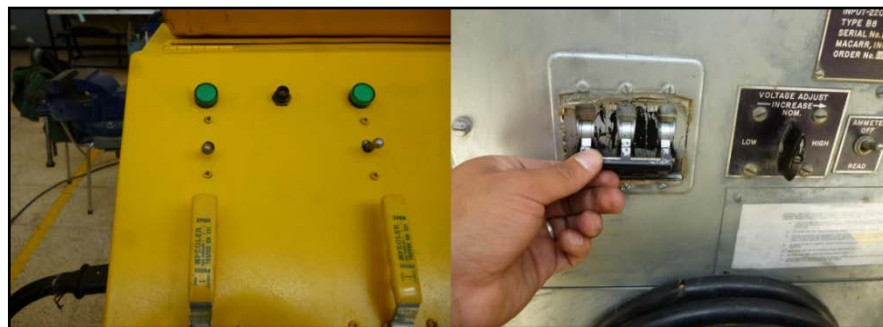
Figura 90. Proceso final de la prueba de funcionamiento
