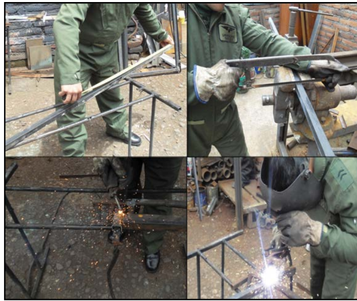
Figura 56. Medida, corte y suelda del tubo cuadrado de la estructura
