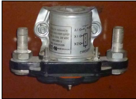
Figura 54. Contactor
