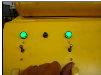
Figura 87. Interruptor de encendido de bomba en posición ON
