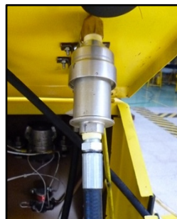
Figura 80. Conexión de las mangueras al filtro
