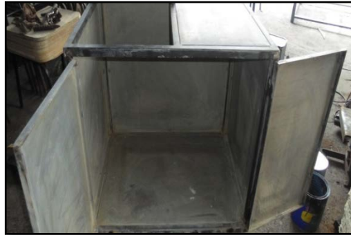
Figura 58. Construcción de las puertas de acceso
