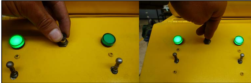
Figura 89. Comprobación del circuit breaker
