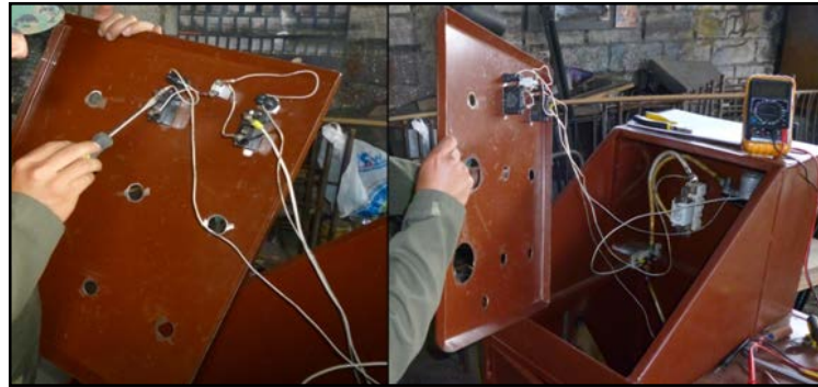
Figura 74. Conexión de dispositivos de indicación y control
