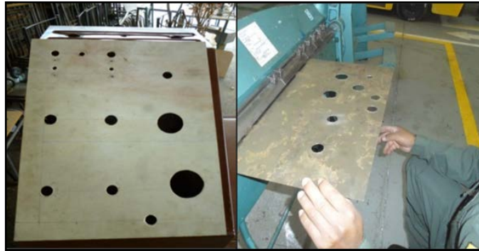
Figura 69. Construcción del panel de indicación y control
