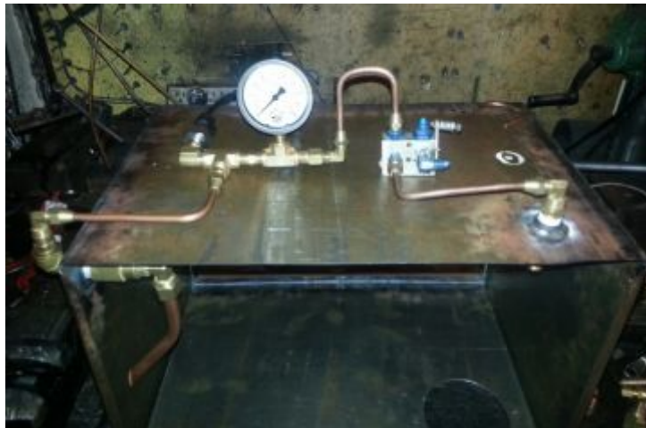
Figura 34 Sistema Tester ensamblado el sistema de cañerías.
