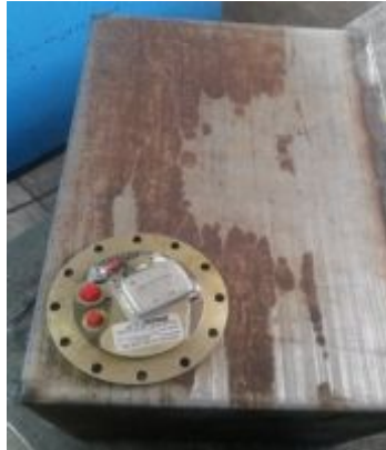
Figura 31 Bomba Booster colocada en el orificio del reservorio
