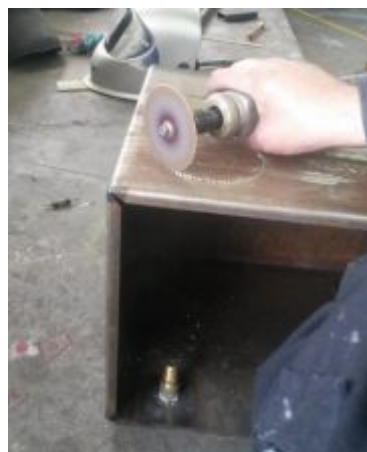
Figura 29 Corte con disco en el reservorio
