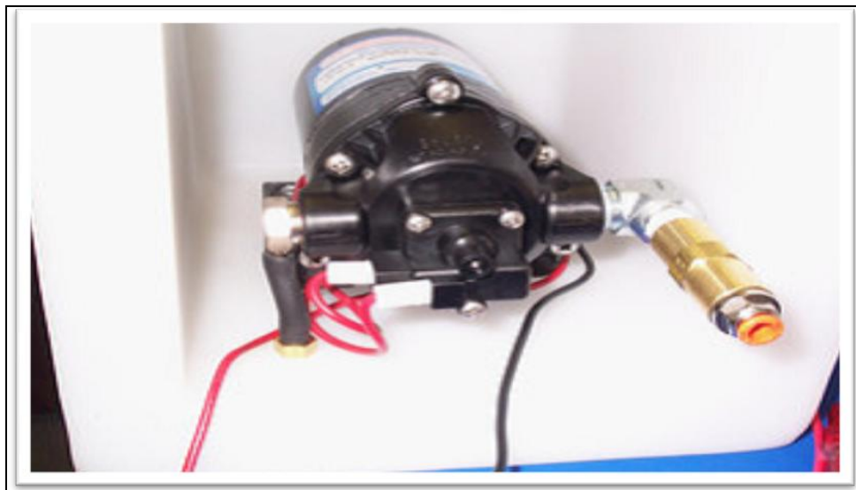
Figura 3.19 – Instalación de la bomba.
