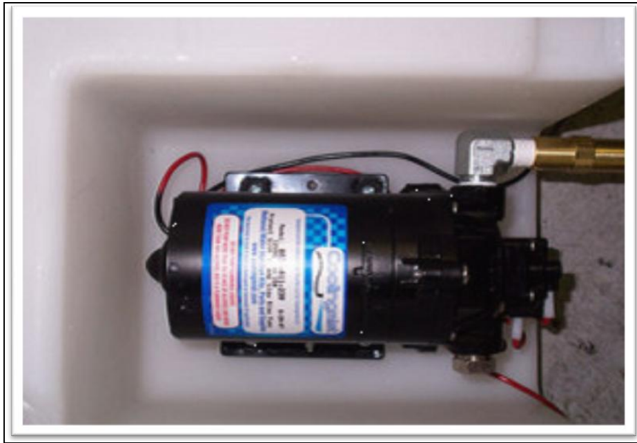
Figura 3.18 – Instalación de la bomba.
