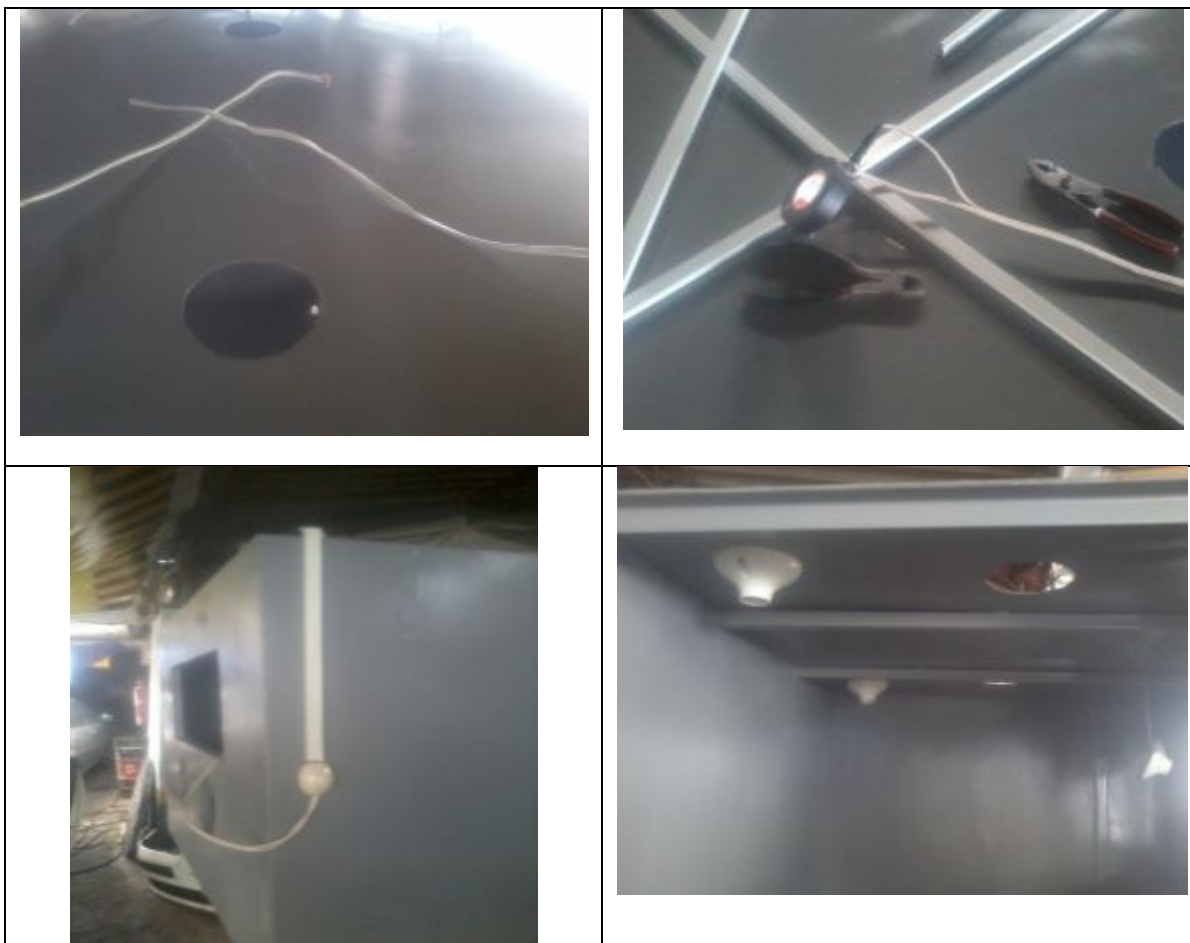
FIGURA 36: INSTALACIÓN CIRCUITO ELÉCTRICO
