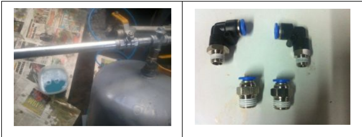
FIGURA 41: INSTALACIÓN SISTEMA DE PRESIÓN
