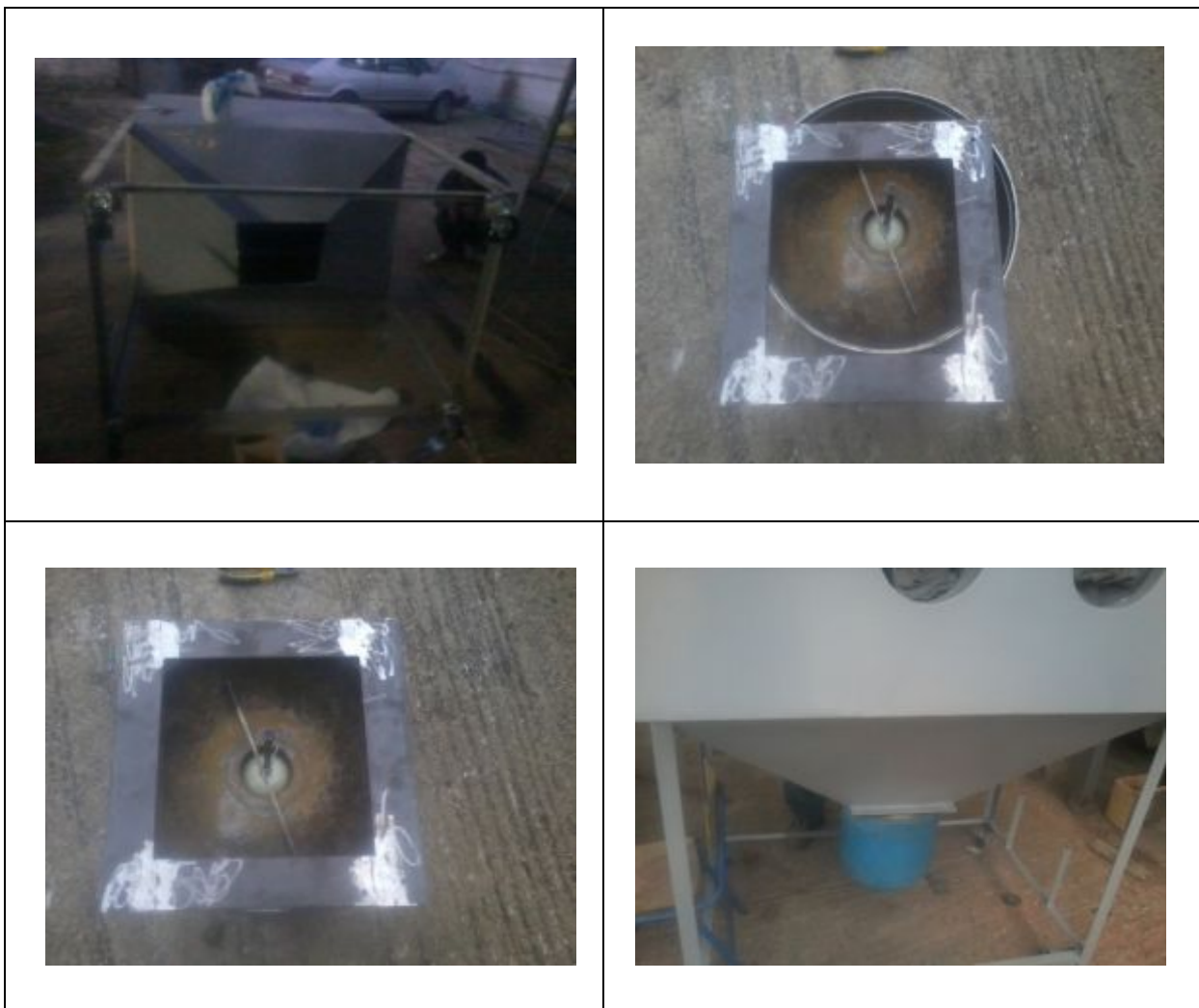
FIGURA 40: PROCESO DE INSTALACIÓN CILINDRO A LA ESTRUCTURA
