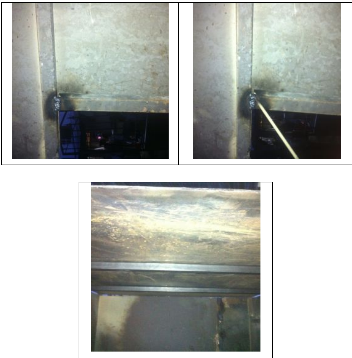
FIGURA 32: PROCESO DE SOLDADO DE ESTRUCTURA
