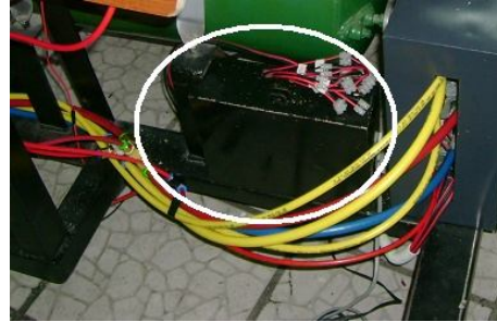
Figura 3.11. Montaje de la Placa Electrónica.
