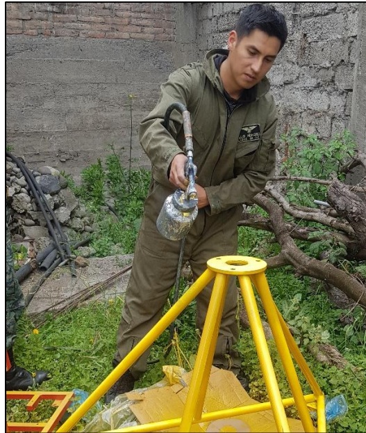
Figura 61. Revestimiento de pintura
