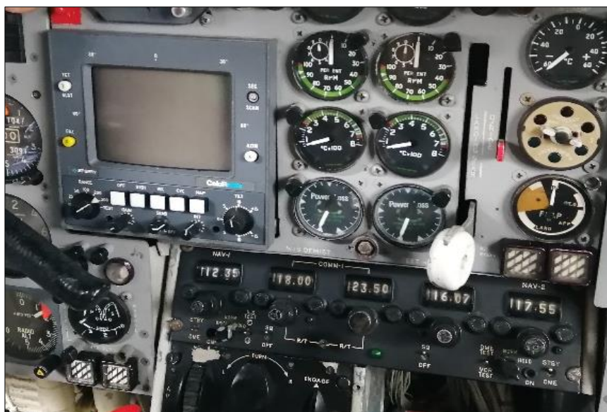
Figura 40. Display del Sistema WXR en Cabina
