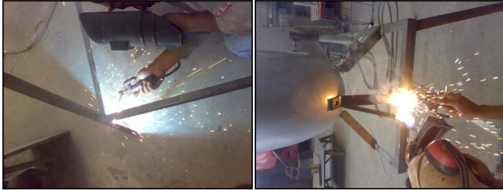
Foto. 3.3. Soldado de la estructura base Fuente: Sr. Cevallos Cruz Luis Carlos
