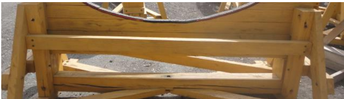
Fig. 3. 15 Colocación del refuerzo trasero
