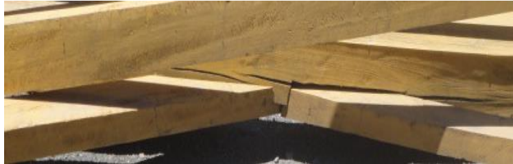
Fig. 3.11 Colocación de los travesaños en la viga central.
