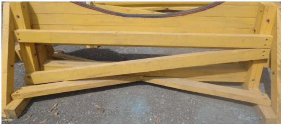
Fig. 3. 14 Colocación de los refuerzos delanteros
