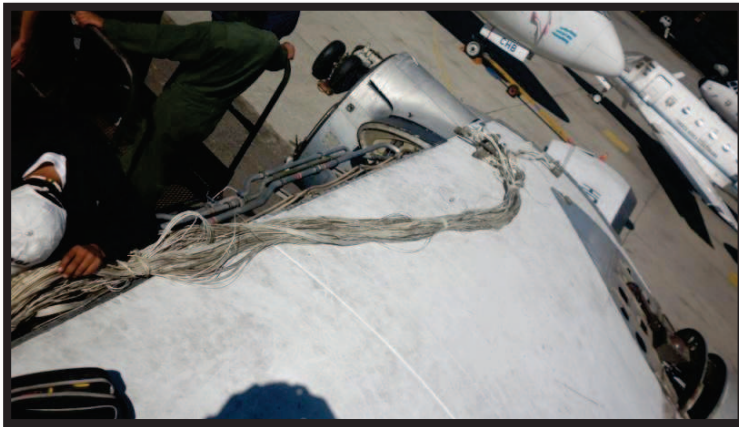
Figura 3.7 Desconexión del sistema eléctrico
