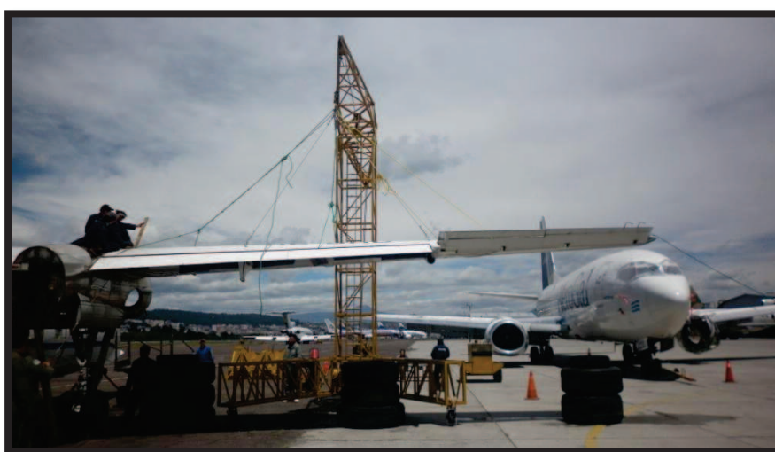
Figura 3.31 Puesta los soportes para colocar el ala
