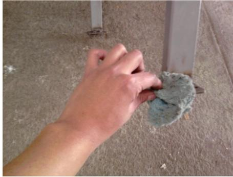
**Fig. 3.74.** Limpieza de la superficie a pintar
