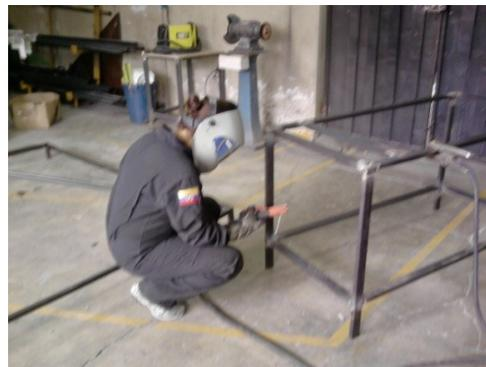
**Fig. 3.70.** Sellado de uniones por soldadura de arco eléctrico
