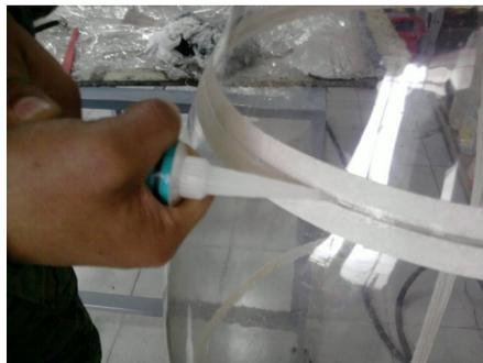
**Fig. 3.57.** Refuerzo de cabina con PRC
