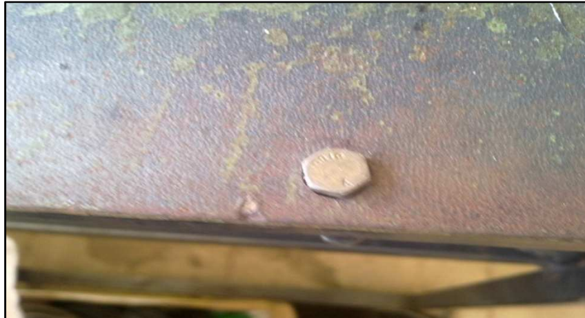
Fig. 32. Sujeción de la plancha de tol a la estructura por medio de pernos.
