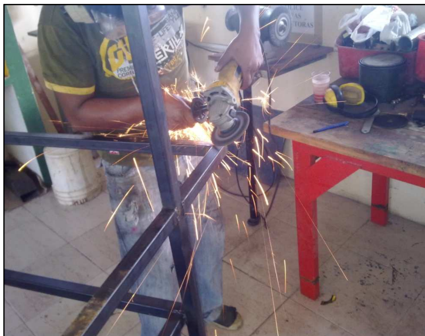
Fig. 30. limado final de la estructura del banco de prueba
