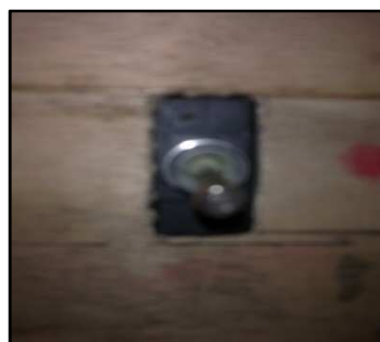
Fig. 60. Máster switch instalado.
