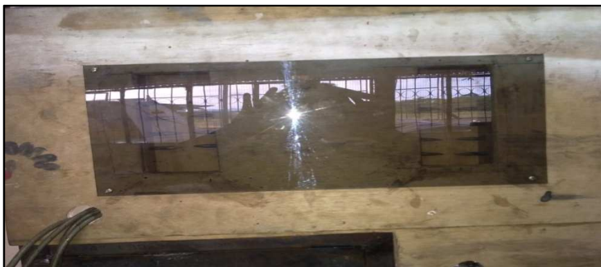
Fig. 57. Instalación de la placa de mica.
