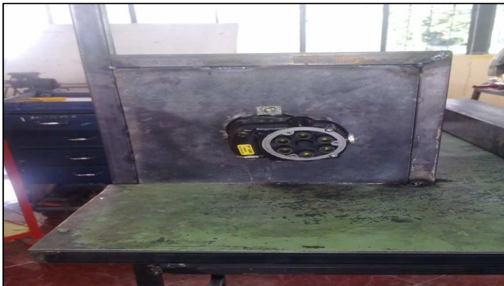
Fig. 34. Suelda de la placa de tol a la estructura.
