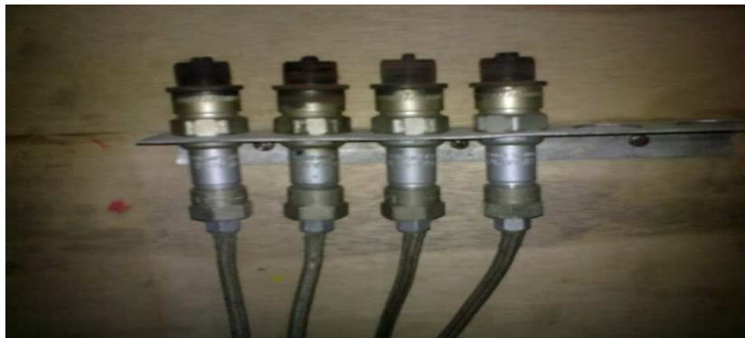
Fig. 56. Instalación del porta bujías y bujías.
