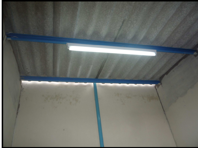
Foto 6.6 Instalación de luz Fuente: Taller de mecánica básica Realizado por: Cbos. Téc. Avc. Cadena David
