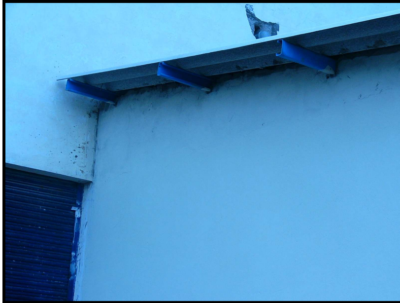
Foto 6.9 Completacion de paredes Fuente: Taller de mecánica básica Realizado por: Cbos. Téc. Avc. Cadena David
