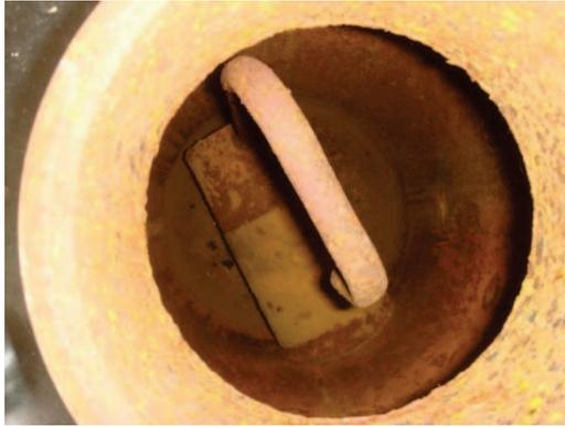
Figura 3.11: Estado de corrosión del generador.
