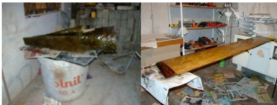
Foto 6.18 Aplicación de la segunda capa de resina epóxica y fibra de vidrio
