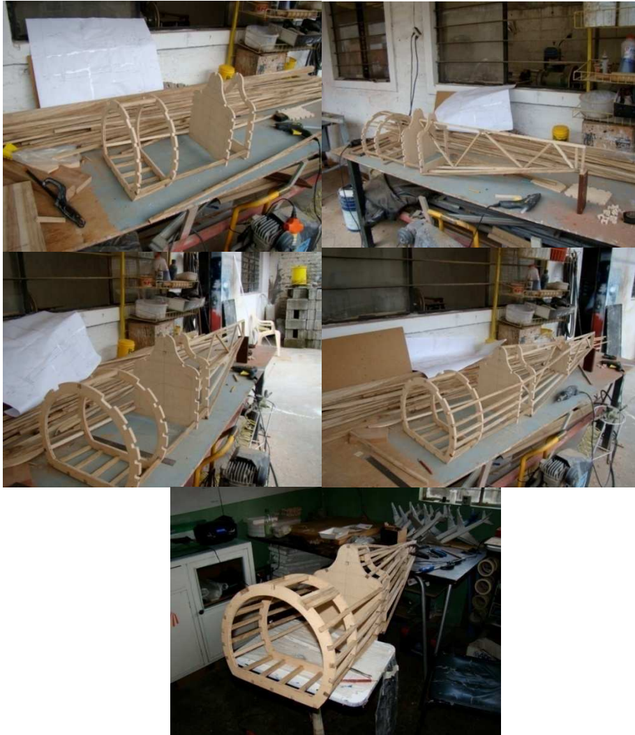
Foto 6.7 Armado de la estructura del fuselaje
