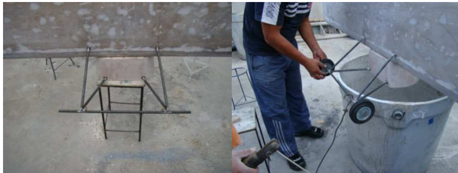
Foto 6.16 Estructura de tubos acero para trenes de aterrizaje
