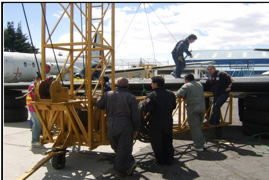
Figura 3.2: Puesta de las eslingas y la grúa
