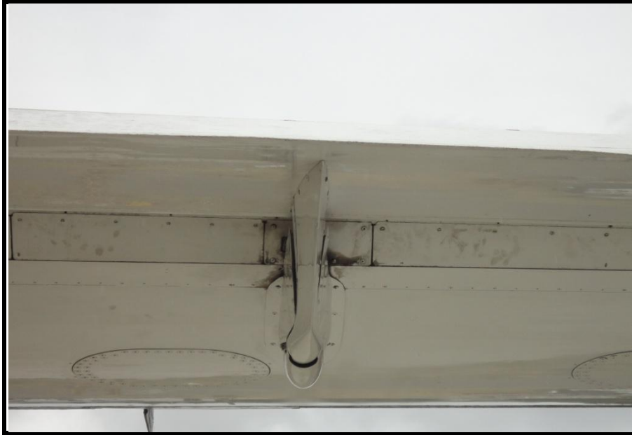
Figura 3.15: Instalación de placas
