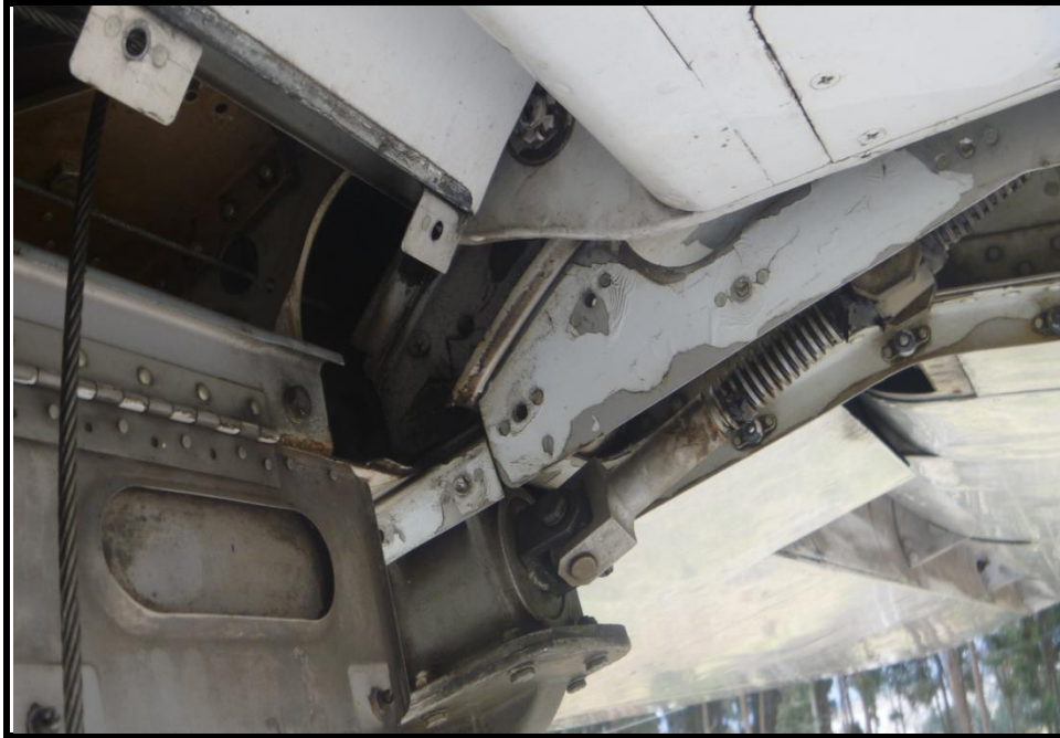
Figura 3.46: Instalación del borde interno del trailing
