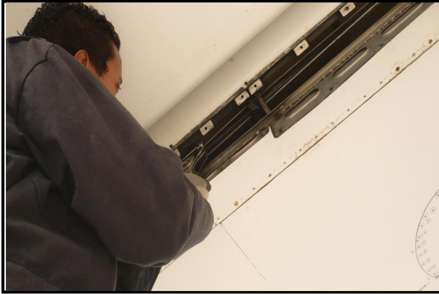
Figura 2.9: Reglaje del cableado
