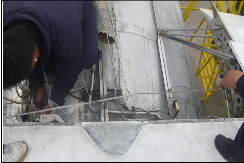
Figura 3.48: Instalación de la barra impulsora
