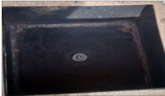
Figura 53: Orificio para drenaje de aceite
