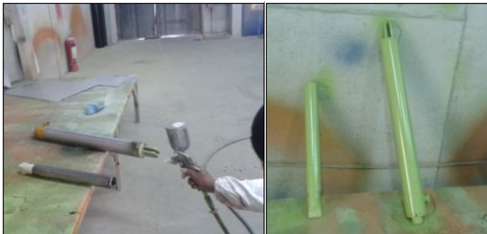
Figura 59: Aplicación de primer en el actuador hidráulico
