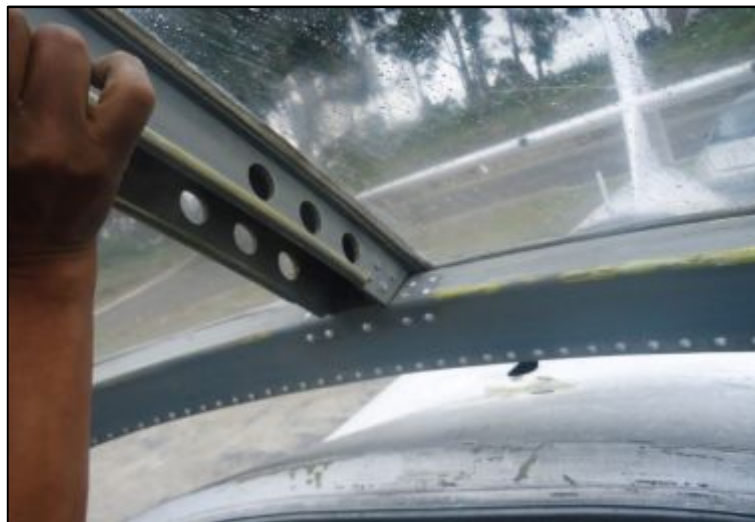
Figura 89: Estructura del canopy lijado
