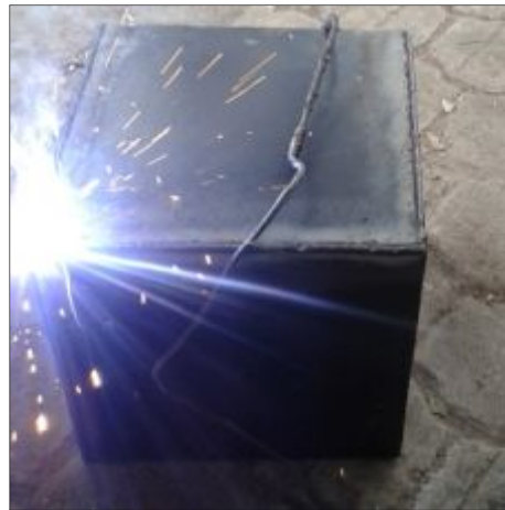
Figura 50: Soldado del reservorio
