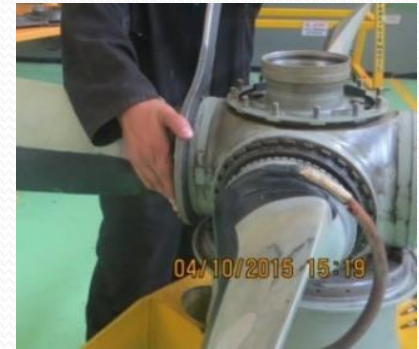
Colocación de la llave de Anillo en el Rodamiento de Pala.
