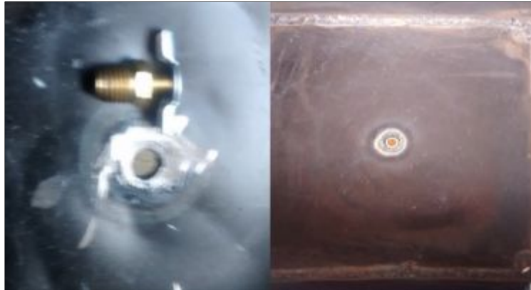
Figura 92 Orificio de drenaje.
