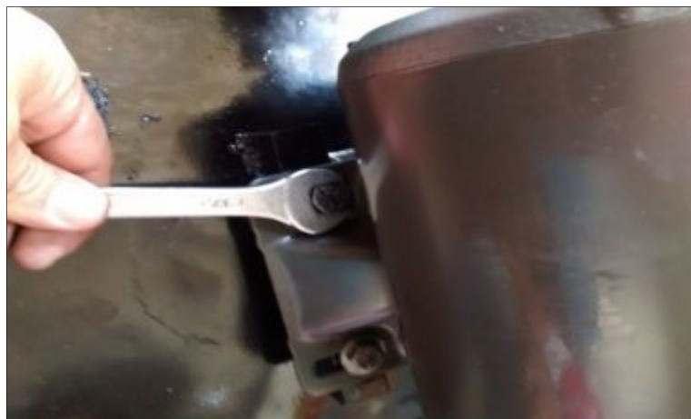
Figura 97 Montaje del motor.
