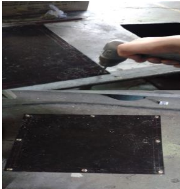
Figura 80 Perforación de la tapa del reservorio
