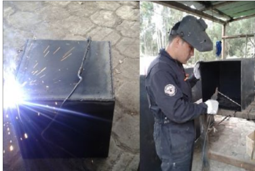
Figura 77 Soldado del reservorio
