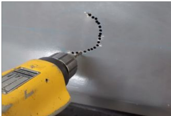
Figura 85 Perforación de orificios
