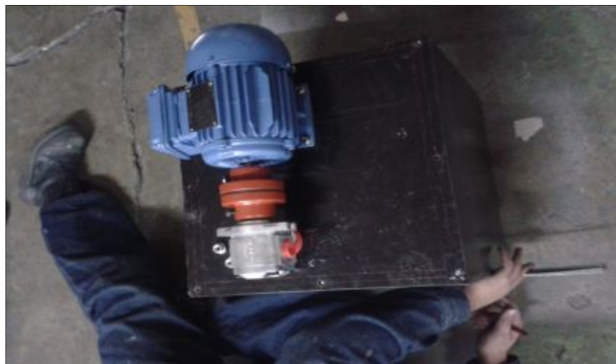
Figura 81 Perforación de orificios para motor y bomba
