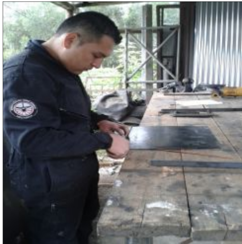
Figura 75 Medición del Reservorio
