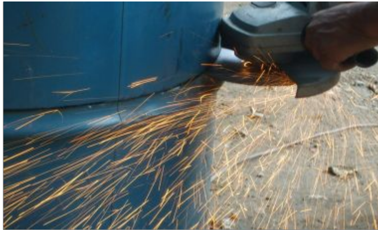
Figura 3.2: Corte del Contenedor metálico
