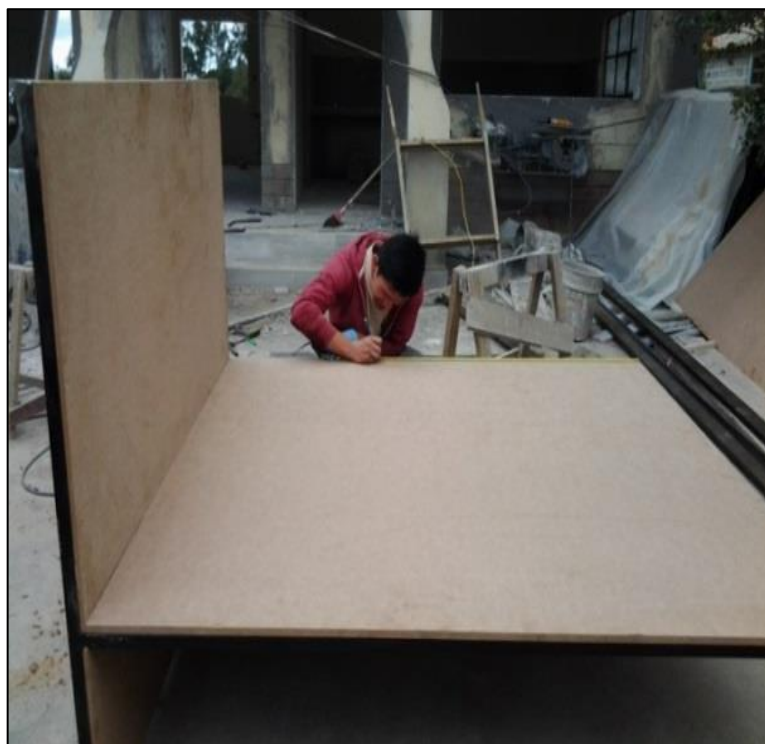
Figura 3.17 Proceso de corte, medida e instalación de la plancha MDF
