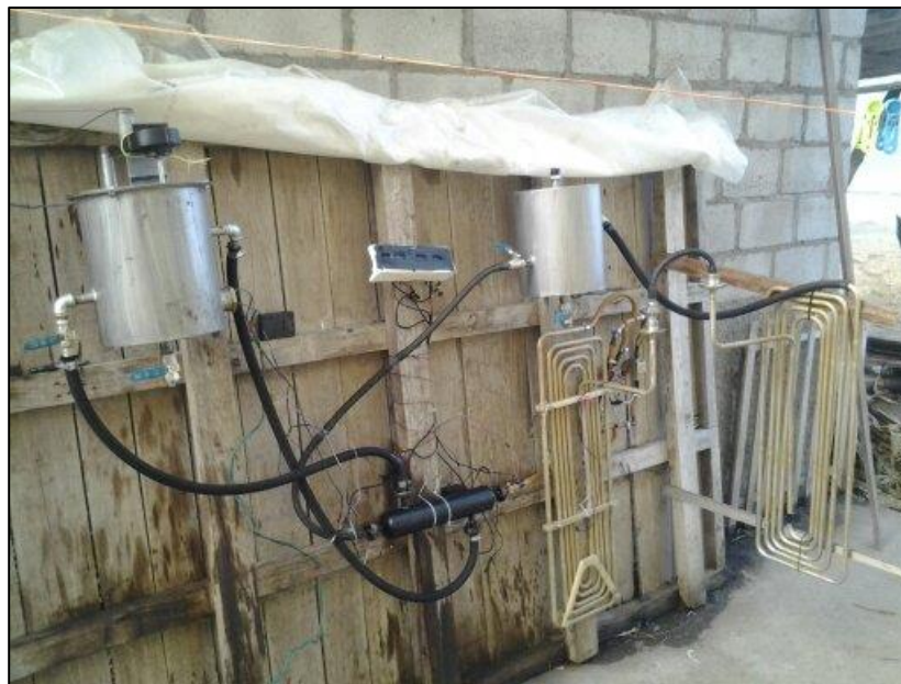
Figura 3.28 Instalación interina del sistema fuel/oil cooler
