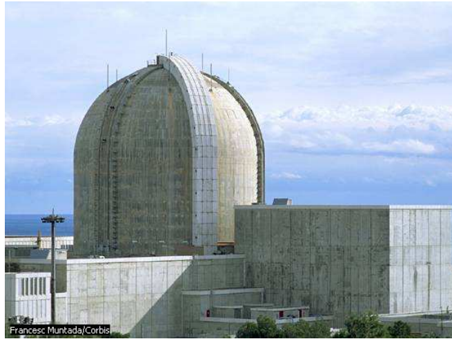
Fig. 1 Central nuclear de Vandellòs
