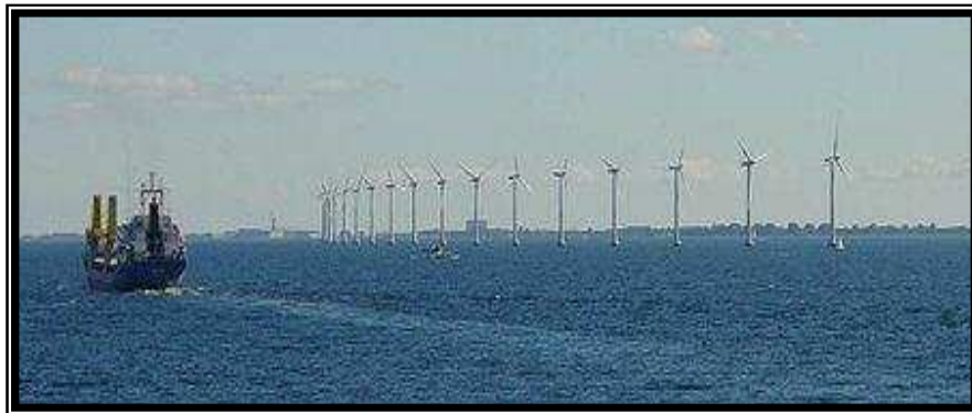
Figura 2.3.1 Parque eólico en el mar ( offshore ), en Copenhague.
