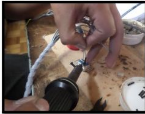
Figura 48. Soldadura de cables positivos a pines de conector
