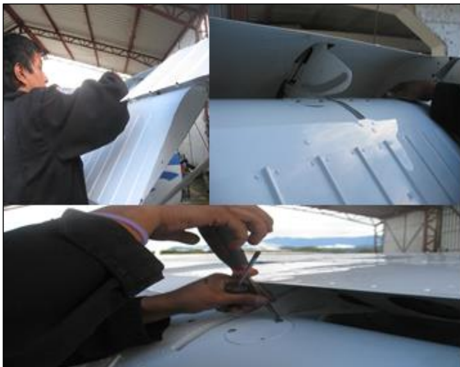
Figura 60. Instalación de los alerones
