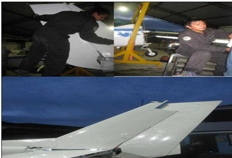
Figura 70. Instalación del rudder
